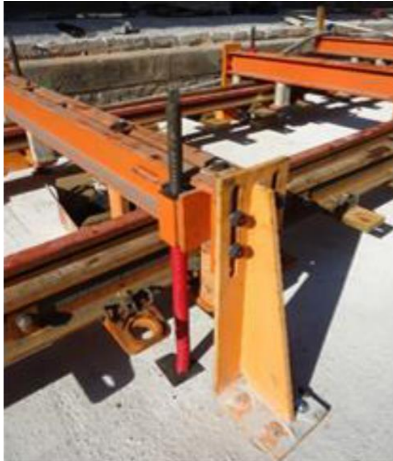
Figura 17. Anclaje de vigas portantes
