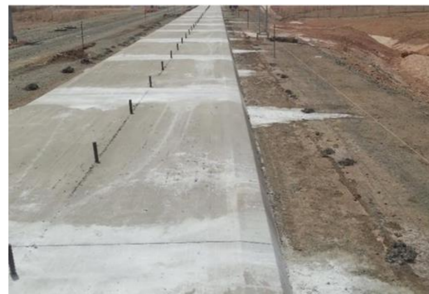
Figura 14. Ejecución de la capa base (prelosa)
