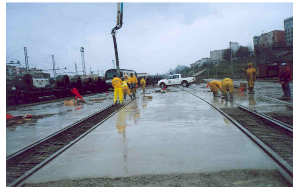
Figura 13. Segunda fase de hormigonado
