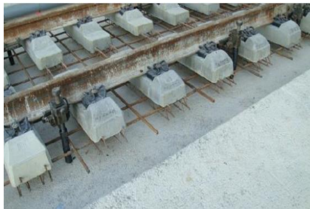
Figura 4. Emparrillado y colocación de husillos de nivelación
