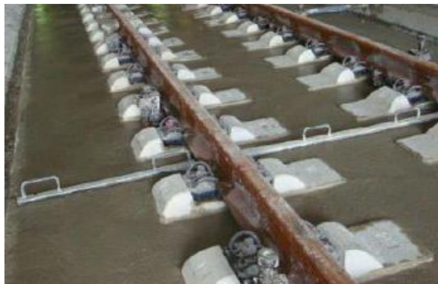
Figura 6. Situación post-hormigonado
