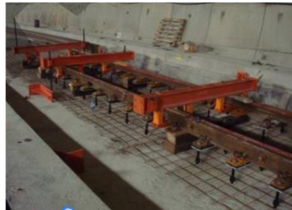
Figura 16. Viga portante con sistema PAD
