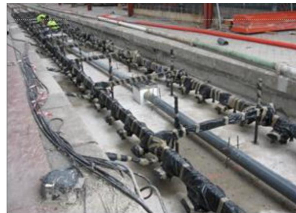
Figura 23. Sistema de drenaje
