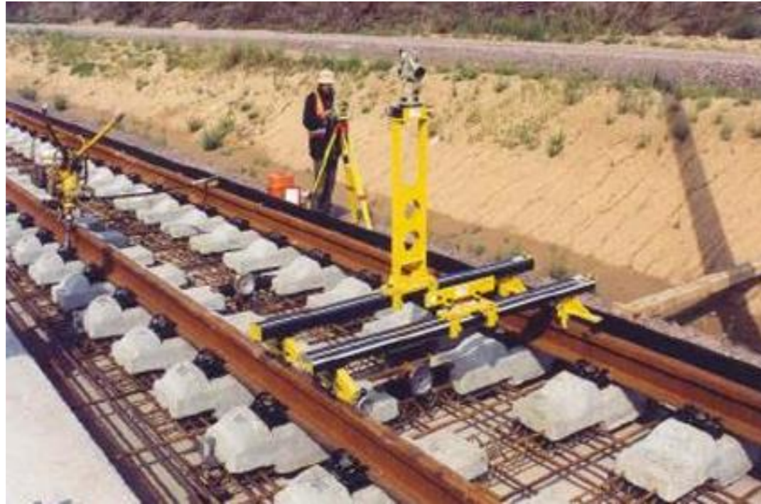
Figura 2. Comprobaciones geométricas previas
