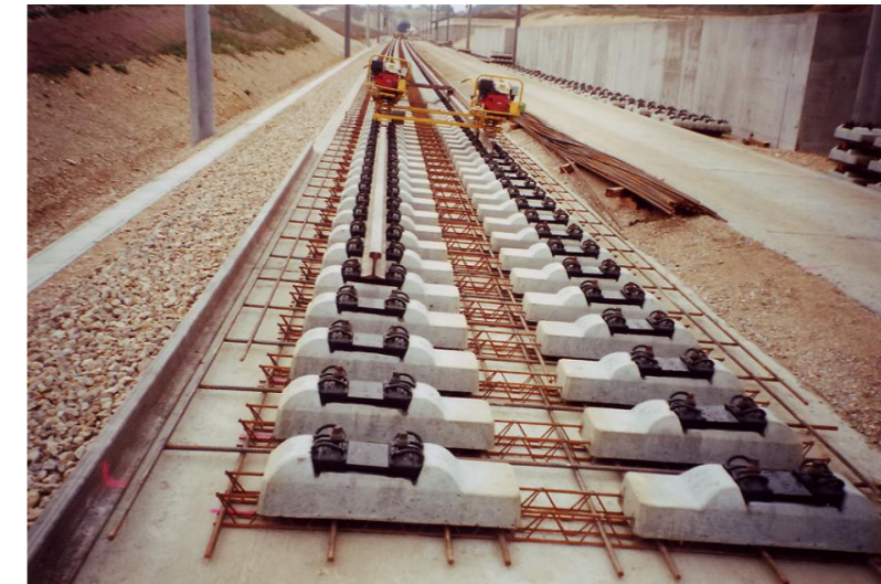
Figura 1. Posicionado de armadura, traviesas y carril
