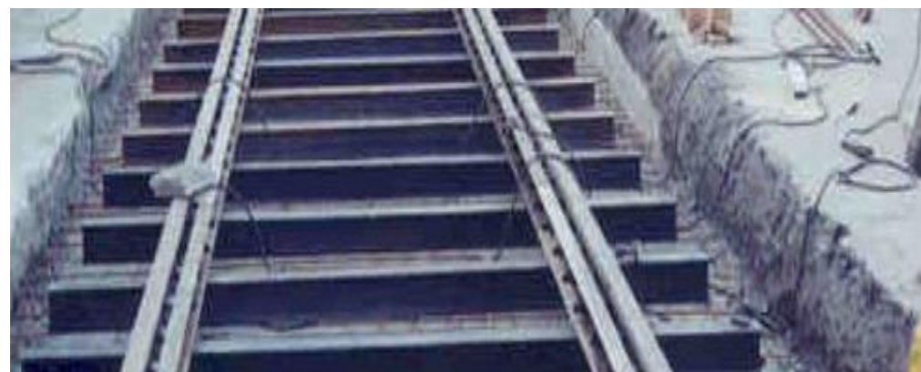
Figura 10. Vía premontada
