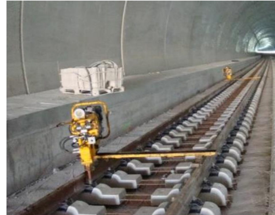
Figura 3. Apriete provisional del carril
